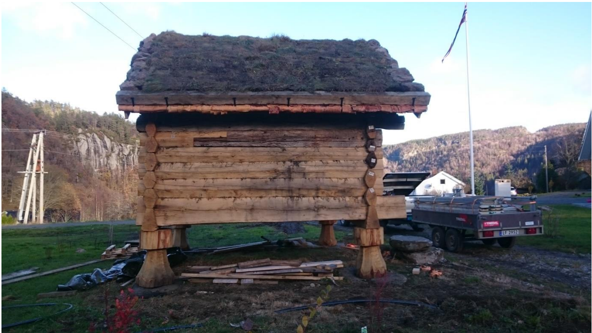
Her kan vi se torvtaket ferdig med steinene på. Og stillaset tatt vekk.
