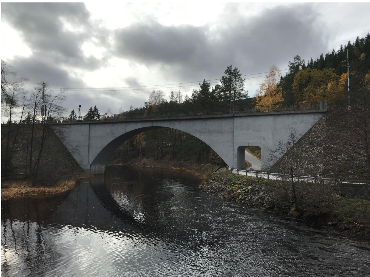
Jernbanebroa ved Audnedal Stasjon. Foto: Maren Holte
