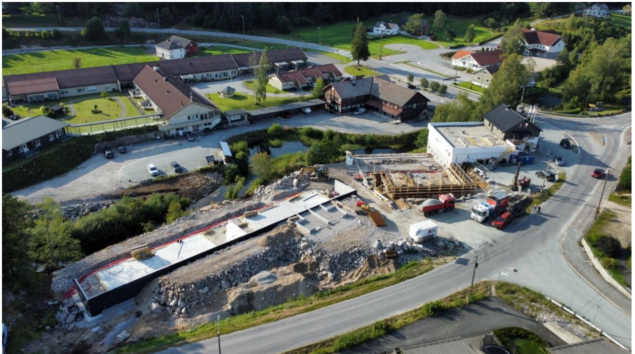
Fig 5. Prosjektet igangsatt – Status Aug. 2023. Eksisterende næringsbygg til høyre.
